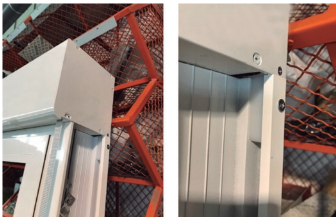
Figura 61. Embudo introducido en guía, con atornillado lateral
