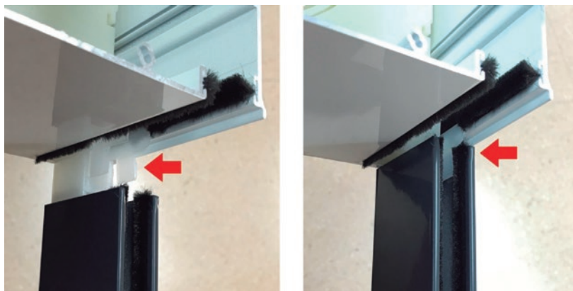
Figura 60. Unión ventana cajón
